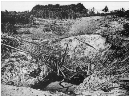
6 Am Ausgangsort der Explosion vom 6.5.1878, deren Druckwelle sogar in Göttingen von der dortigen Sternwarte registriert wurde, entstand ein „30 Fuß tiefer Krater“.
