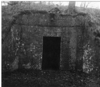
10 Wahrscheinlich handelt es sich bei diesem erst nach der Fabrikschließung aufgenommenen Bild um eines jener Pulvermagazine, die in den Elbhag eingebettet waren.
