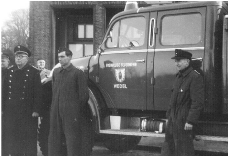
von rechts: Gerätewart Karl Kunke, Zugführer Hans Uve Köhler, Wehrführer Hans Köhler, im Hintergrund Stadtinspektor Karl Hinz, Leiter des Ordnungsamtes
