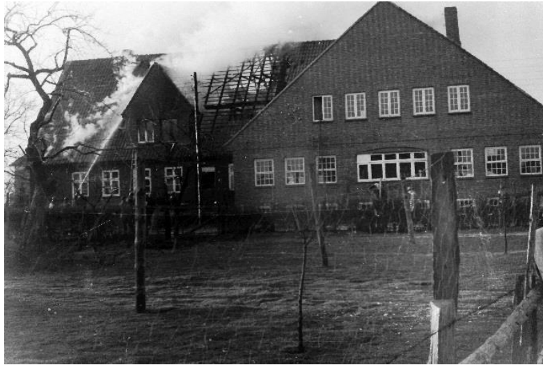
Ansicht der Einsatzstelle von der Wiedestraße
