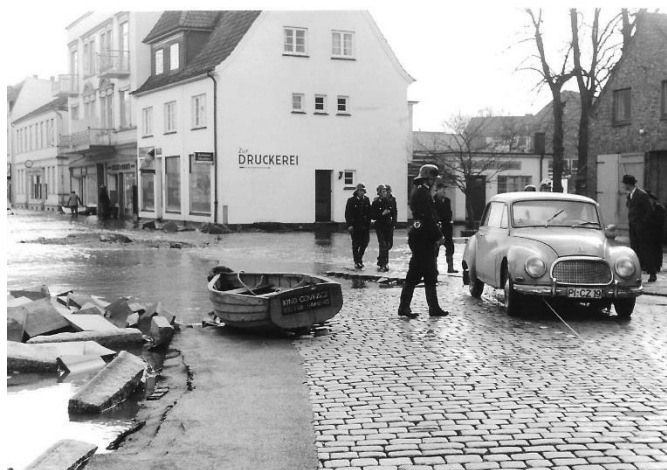
Die ersten Aufräumarbeiten beginnen.
