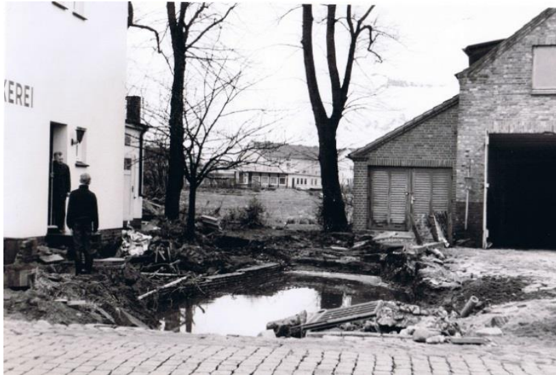
Durch diese Lücke wurde das Boot in Richtung Aue getrieben
