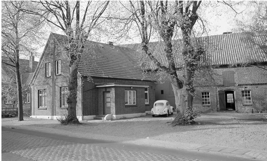
Das 1923 fertiggestellte Röttger'sche Bauernhaus. hier ein Bild um 1960
