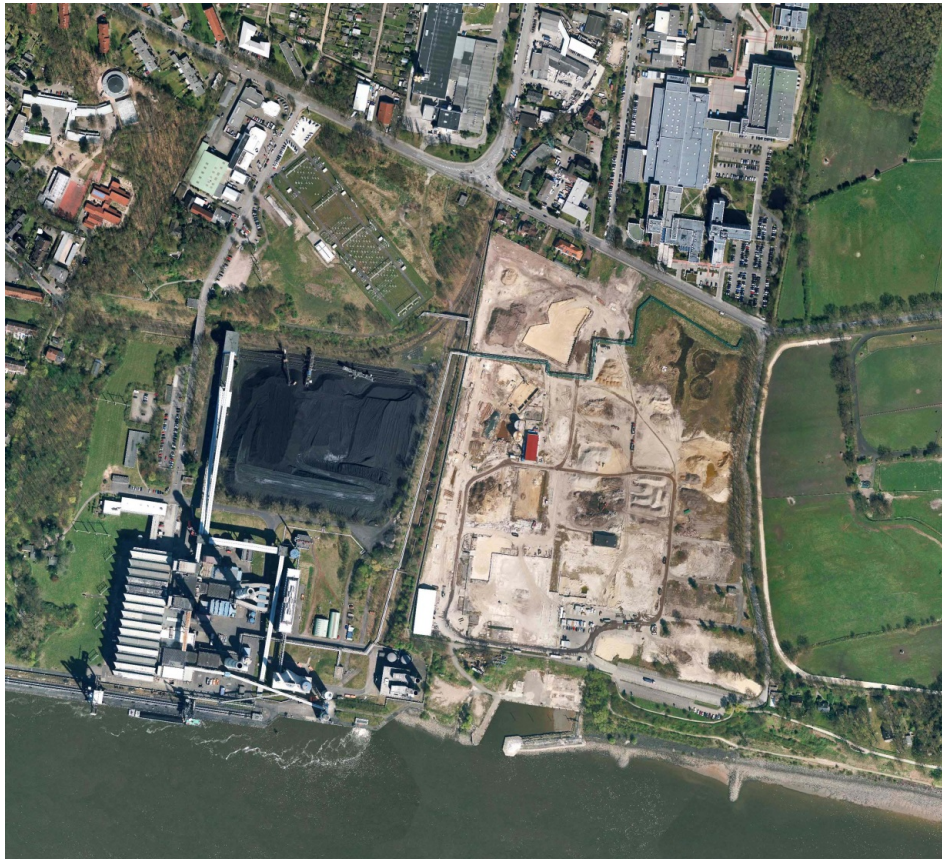
Abb. 3: Luftbild 2008 mit den Sanierungsmaßnahmen nach Beseitigung der baulichen Anlagen
